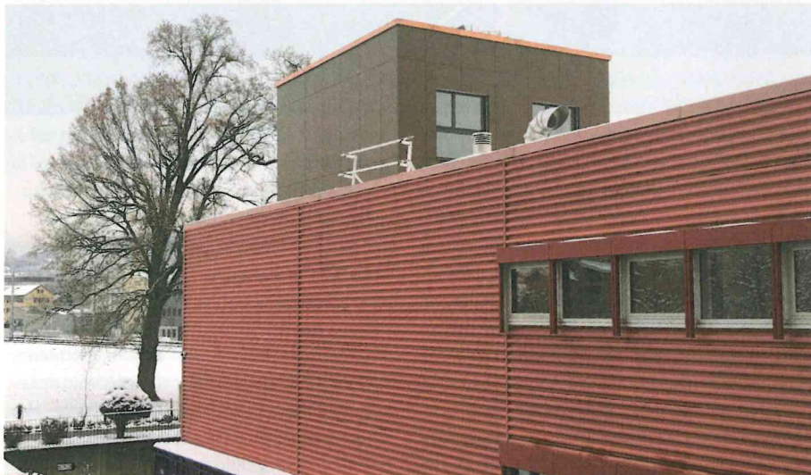
Das Ziel des „perfekten Hauses“ an der Hochschule in Luzern ist, die Gebäudetechnik so weiter zu entwickeln und ressourcenschonendes Heizen, Lüften und Kühlen und Umweltschutz und Komfortbedürfnisse der Menschen zusammenzubringen
