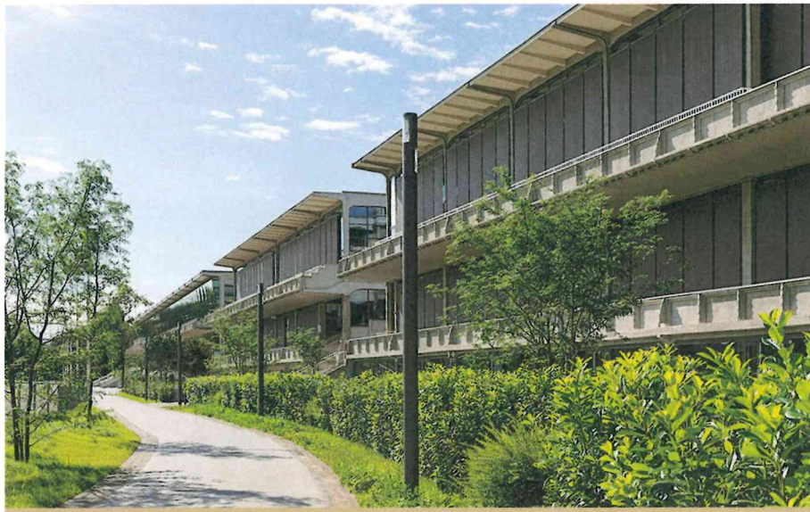
Die Tribünen Krieau aus dem Jahr 1878 wurden u. a. mit zwei Sole-Wärmepumpen und 91 Erdsonden ertüchtigt
